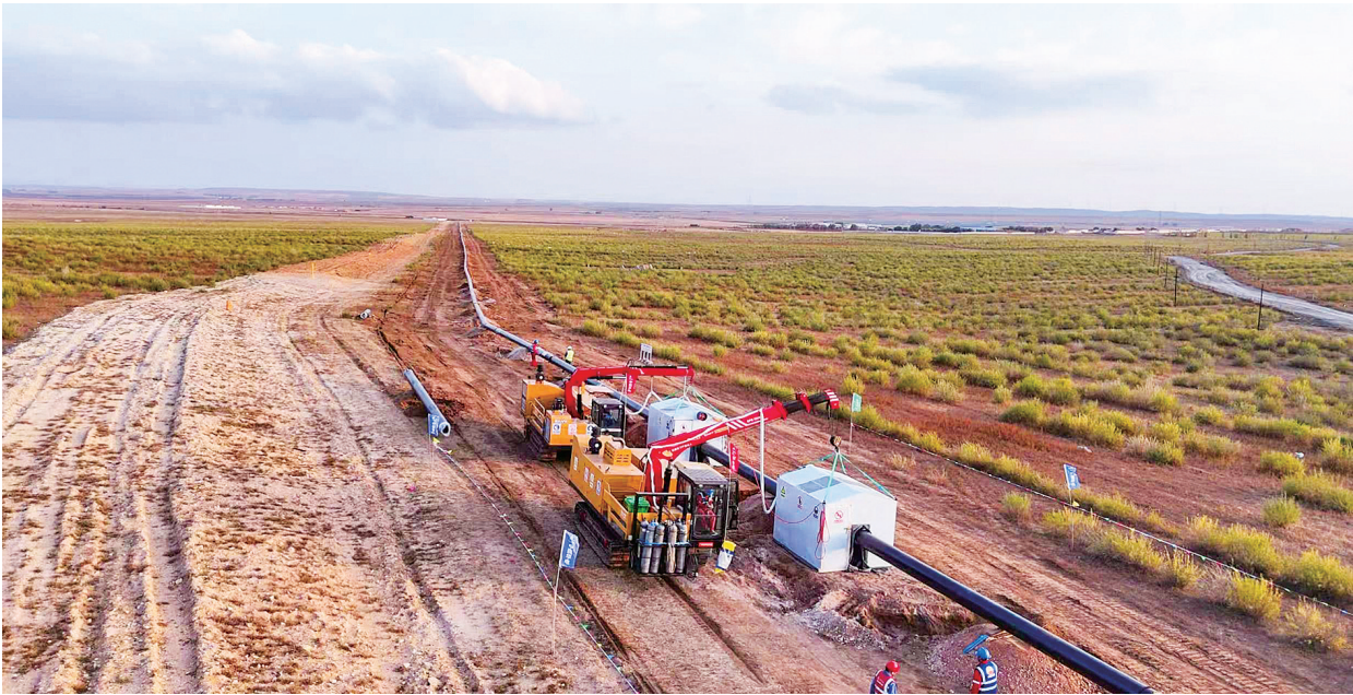
近日,内蒙古自治区白云鄂博至包头市区氢气长输管道工程氮气置换圆满成功,该氢气长输管道工程是国家能源局首批氢能试点的核心工程,全长195公里。(内蒙古华电氢能科技有限公司供图)
