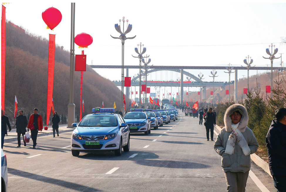
2019年12月31日,连接甘肃兰州红古区与青海海东民和县的川海大桥正式通车,两地核心城区通行里程压缩至6公里,通行时间缩短一半。(兰州市交通运输委办公室供图)
