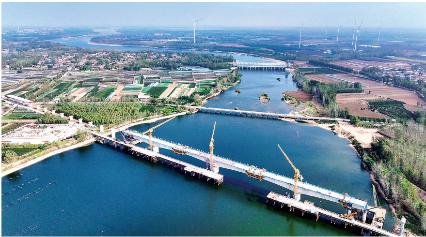
近日,国家重点工程潍(坊)宿(迁)高铁跨沭河连续梁顺利合龙。潍宿高铁是京沪高铁辅助通道重要组成部分,将便利沂蒙山与苏北革命老区群众出行,助力区域经济发展。
