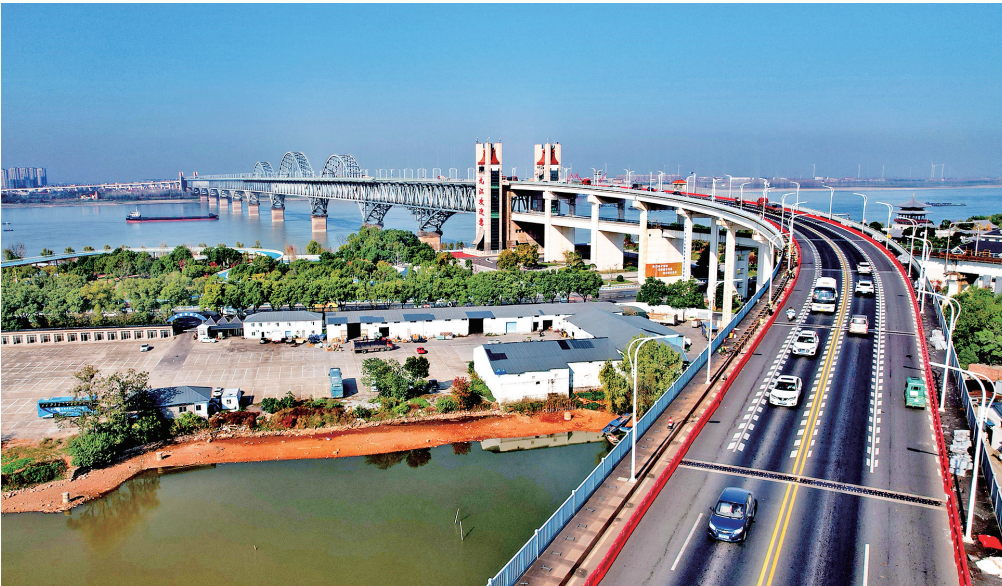
连接江西九江市与湖北黄冈市的九江长江大桥，是京九铁路的大动脉，也是连通长江南北的重要交通要道。这座大桥全长7675米，主桥长1806米，为双层结构公铁两用桥。上层为公路，下层为铁路，桥下货船全天候往来穿梭。（湖北黄冈市委改革办供图）
