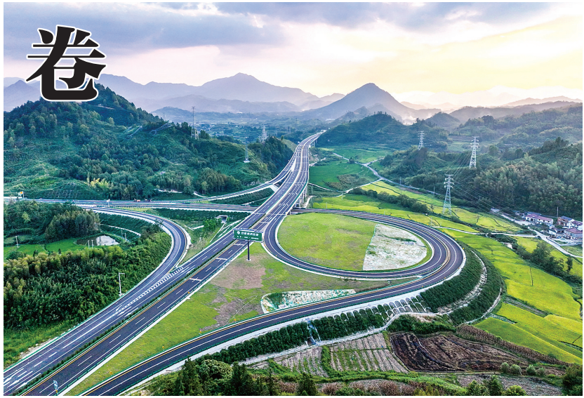
图为中交隧道局承建的安吉至旌德高速公路宁国至旌德段旌德北互通。
