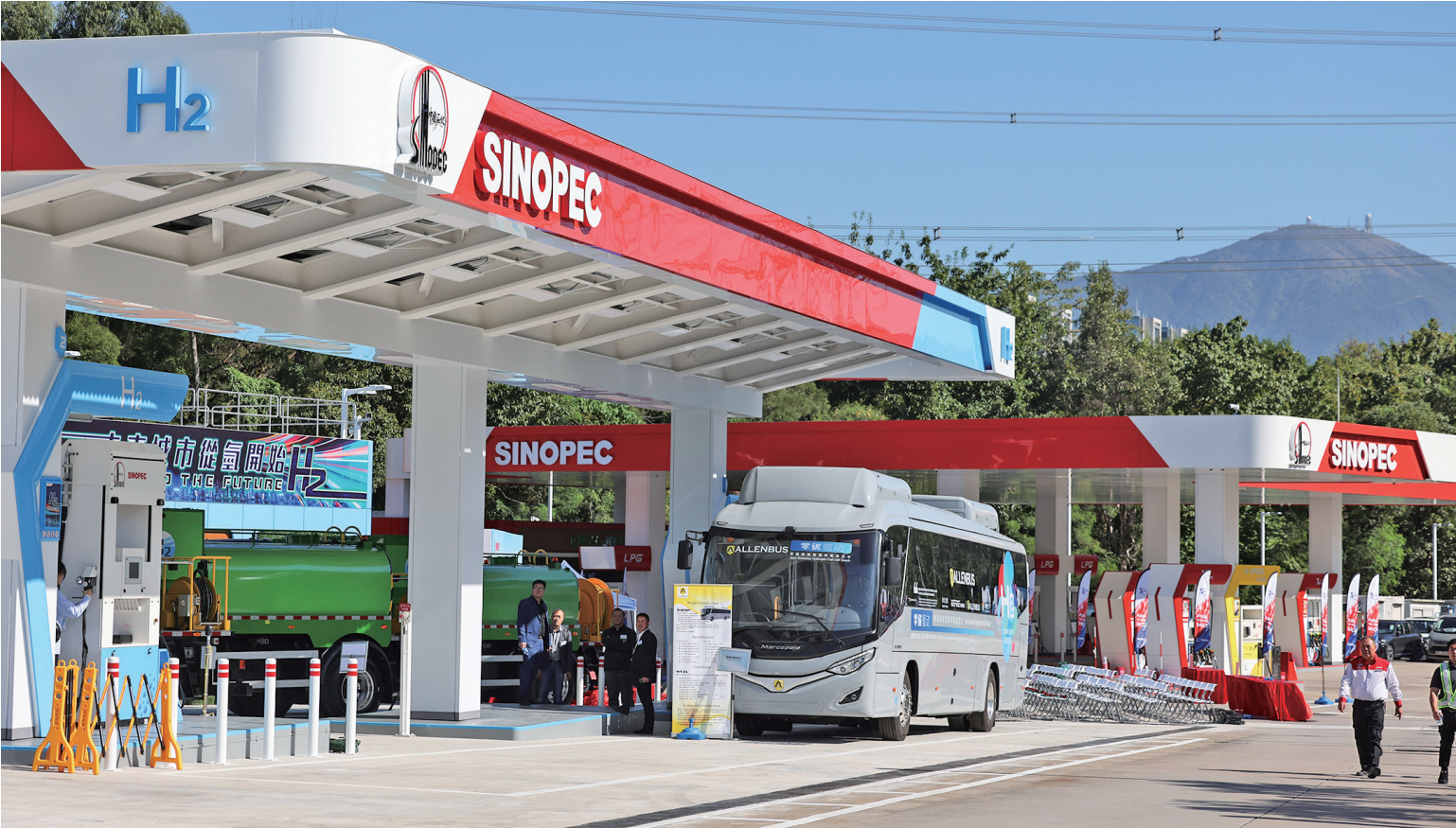
国家发展改革委等三部门近日正式批复5个城市群开展氢能综合应用试点,意味着我国氢能产业开启规模化发展新篇章。图为中国石化在境外建设的首座加氢站——香港凹头加氢站。该站是集“油气氢电服”于一体的综合能源站,每日加氢能力达1000公斤,可为公共巴士、私家车等提供全天候加氢服务,助力香港绿色能源转型。
