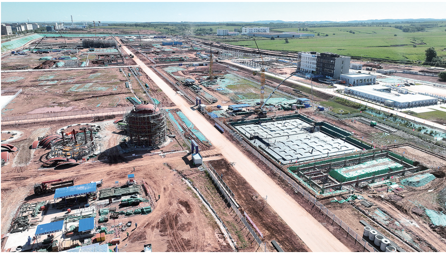
梨树风光制绿氢生物质耦合绿色甲醇项目建设现场。 (四平新型工业化经济开发区供图)
