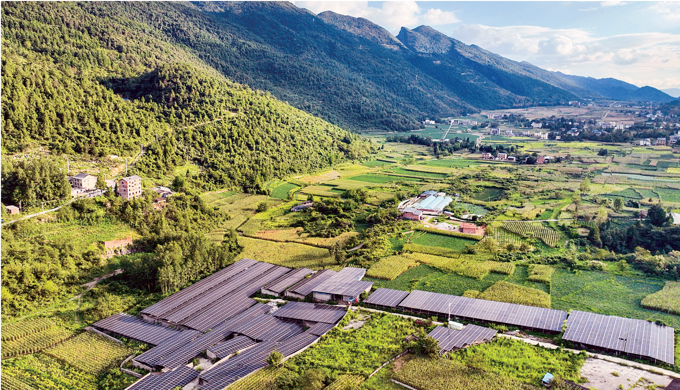
重庆市石柱县三星乡五斗村分布式光伏项目
