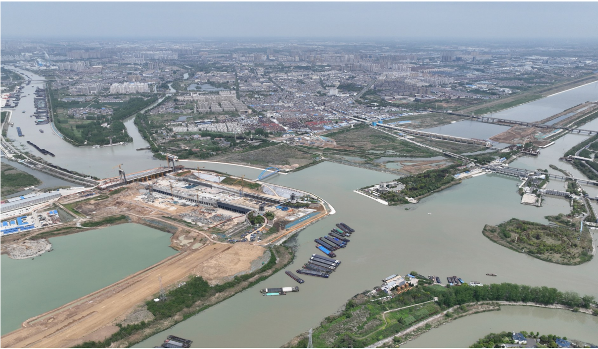
淮河入海水道二期江苏淮安枢纽工程建设现场
