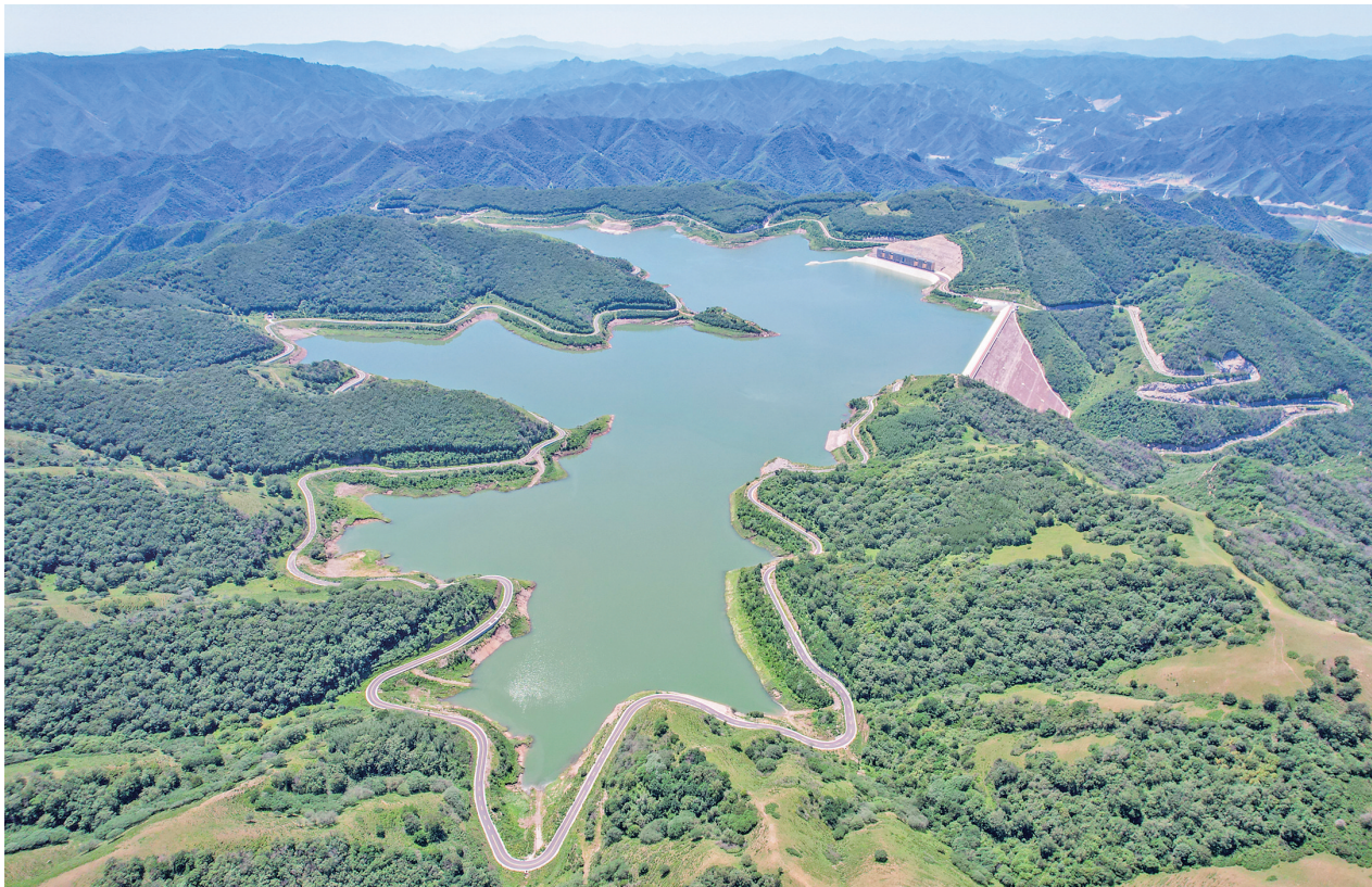
总装机为360万千瓦的河北丰宁抽水蓄能电站,是目前世界装机容量最大的抽水蓄能电站。(中国电建北京院供图)
