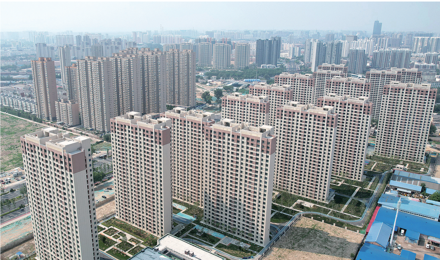
“十四五”时期，我国建设筹集各类保障性住房和城中村、城市危旧房改造等安置住房1100多万套（间），累计改造城镇老旧小区24万个。图为河北省保定市城中村改造三期工程南刘各庄村安置区楼房。
