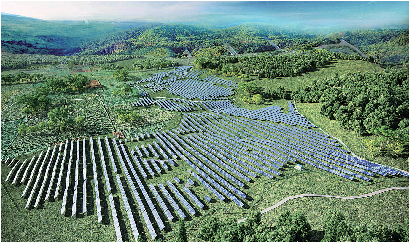
夏张镇一期30000MW光伏复合发电项目推动产业绿色低碳发展。
