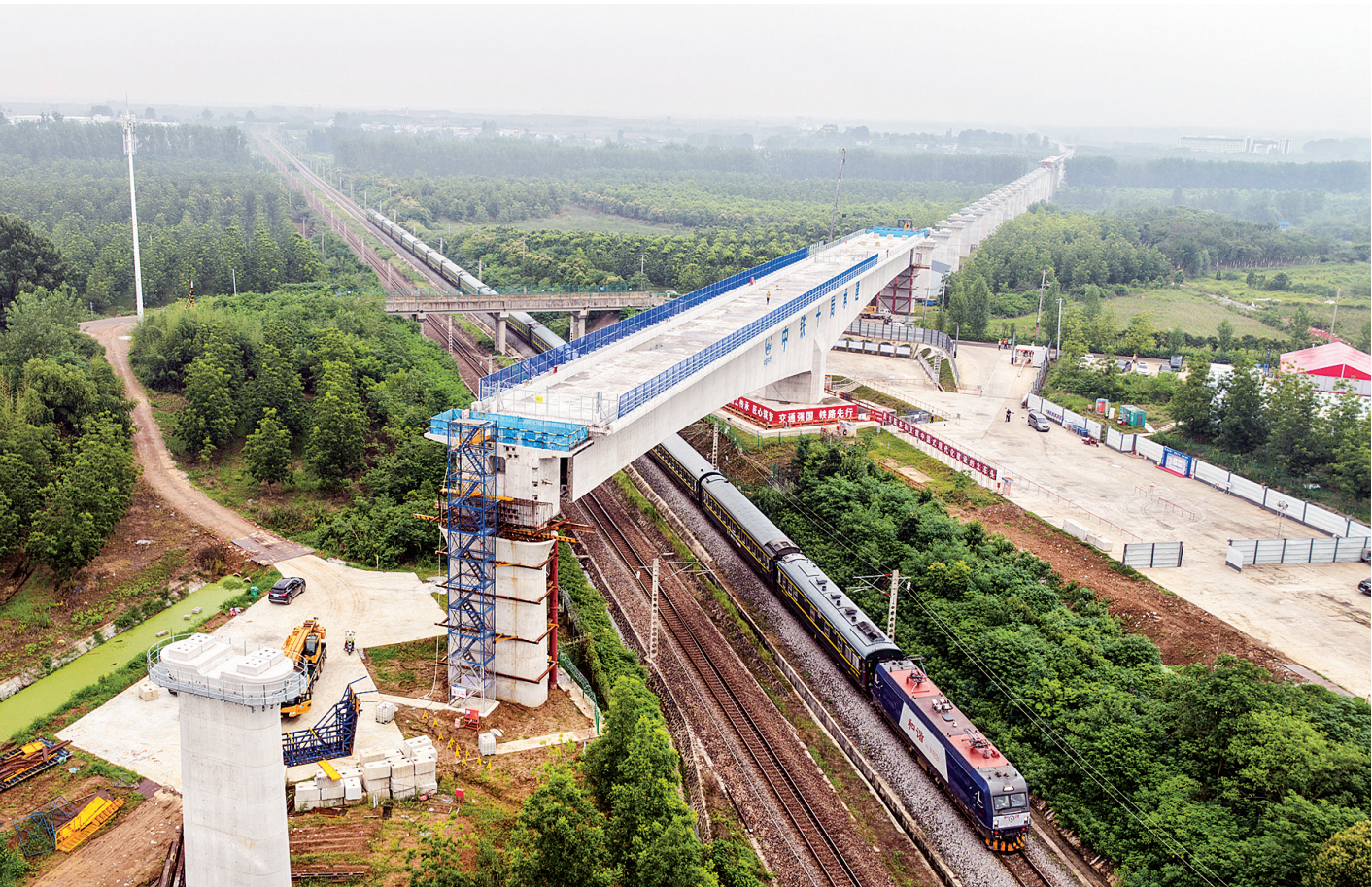
6月25日，在安徽省合肥市肥西县境内，由皖赣铁路安徽公司建设管理、中铁十局承建的合武高铁庐安特大桥跨宁西铁路200米T构连续梁成功完成35度“空中转体”。该梁总重1.5万吨，此次成功转体标志着全线架梁通道建设取得阶段性进展，为后续无砟轨道施工奠定了坚实基础。合肥至武汉高速铁路是我国“八纵八横”高铁网沿江通道的重要组成部分，正线全长约360公里，设计时速350公里。图为转体后的合武高铁庐安特大桥跨宁西铁路万吨连续梁。
