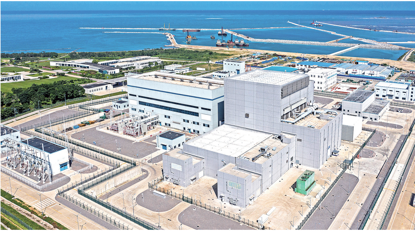
夏日时节，用电高峰如期而至。全国水、风、光、火超40亿千瓦装机统筹联动，让各地电源按需调配，稳稳托举全社会用电需求。图为华能石岛湾高温气冷堆示范工程外景。
