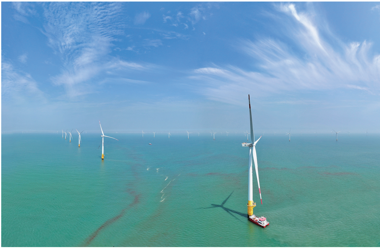
今年1-5月,江苏如东H4、H7海上风电场发电量达8.8亿千瓦时。该项目自2021年12月投产以来,累计发电量达102.6亿千瓦时。图为如东H4海上风电场日常维护作业现场。
