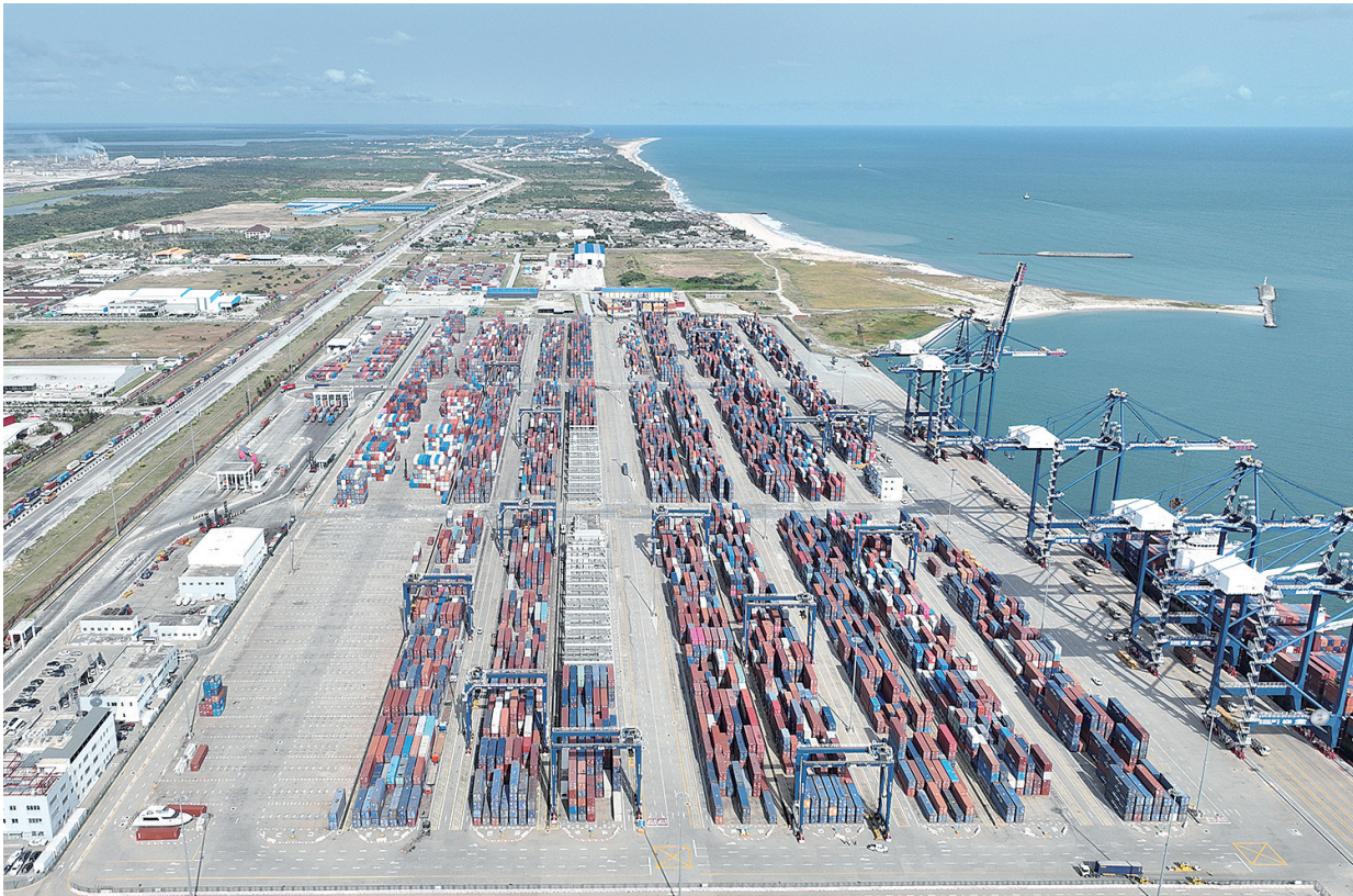
中国自2026年5月1日起对53个非洲建交国全面实施零关税举措。中国超大市场将为非洲发展带来前所未有的新机遇,必将为中南贸易投资合作和非洲经济现代化注入强大动力。图为尼日利亚莱基深水港。
