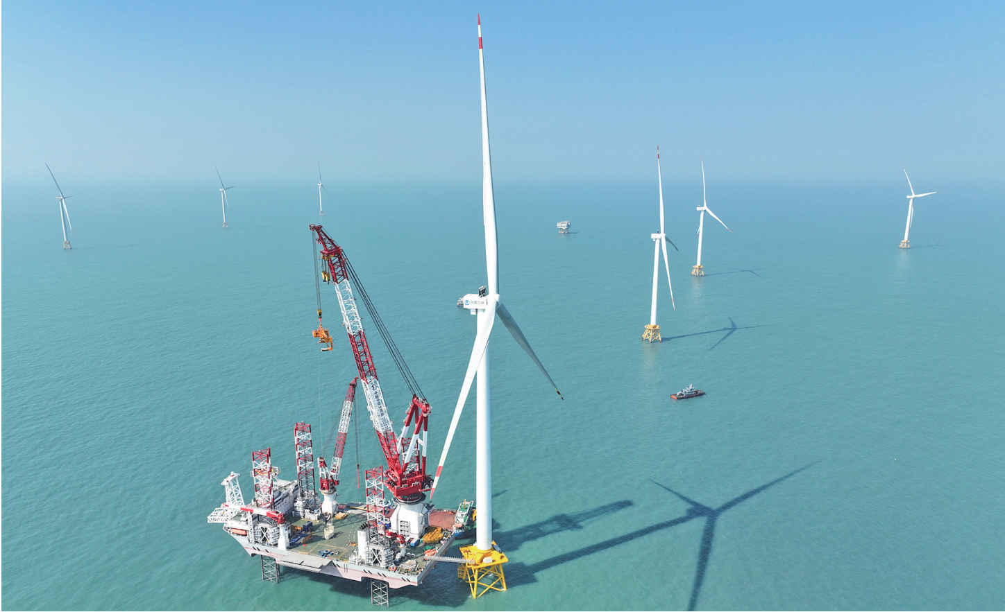
位于福建海域的20兆瓦海上风电机组和“大桥海风”号2000吨自升式海上风电安装平台。
