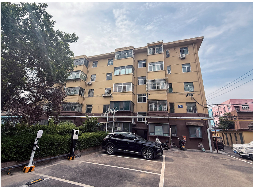
济南市济泺路65号院户表改造完成后,户均容量大幅提升,配套新建7千瓦充电桩9个,有效解决群众充电难题。
