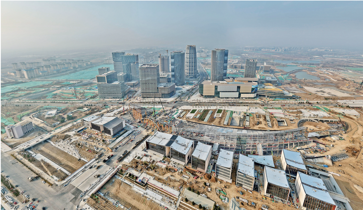
“十四五”以来,雄安新区扎实推进大规模建设与承接北京非首都功能疏解,每年保持2000亿元投资规模,累计完成投资工作量超10000亿元,实现了拉框架、显雏形、展五新、聚要素、上台阶目标任务,一年一个节点、每年一个模样,从无到有、从蓝图到实景。图为雄安新区启动区建设现场。
