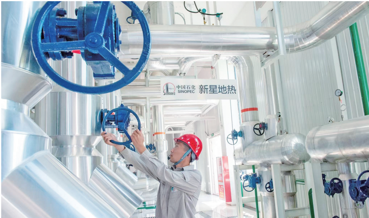
中国石化日前提出,在“十五五”期间实现二氧化碳捕集、利用与封存600万吨以上的目标。图为中国石化新星公司工作人员巡检设备。
