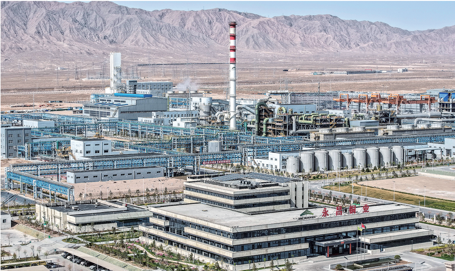
甘肃省金昌市是全国最大的镍钴生产基地之一，素有“镍都”美誉。近年来，当地全力培育尾矿、冶炼废渣、磷石膏等8条细分产业链为支撑的资源综合利用产业集群，推动工业固废实现稀贵金属梯次提取、新型建材与土壤改良剂资源化制备，成功蹚出一条点废成金、低碳增效、绿色转型的高质量发展新路径。图为金川集团永昌铜业有限公司。
