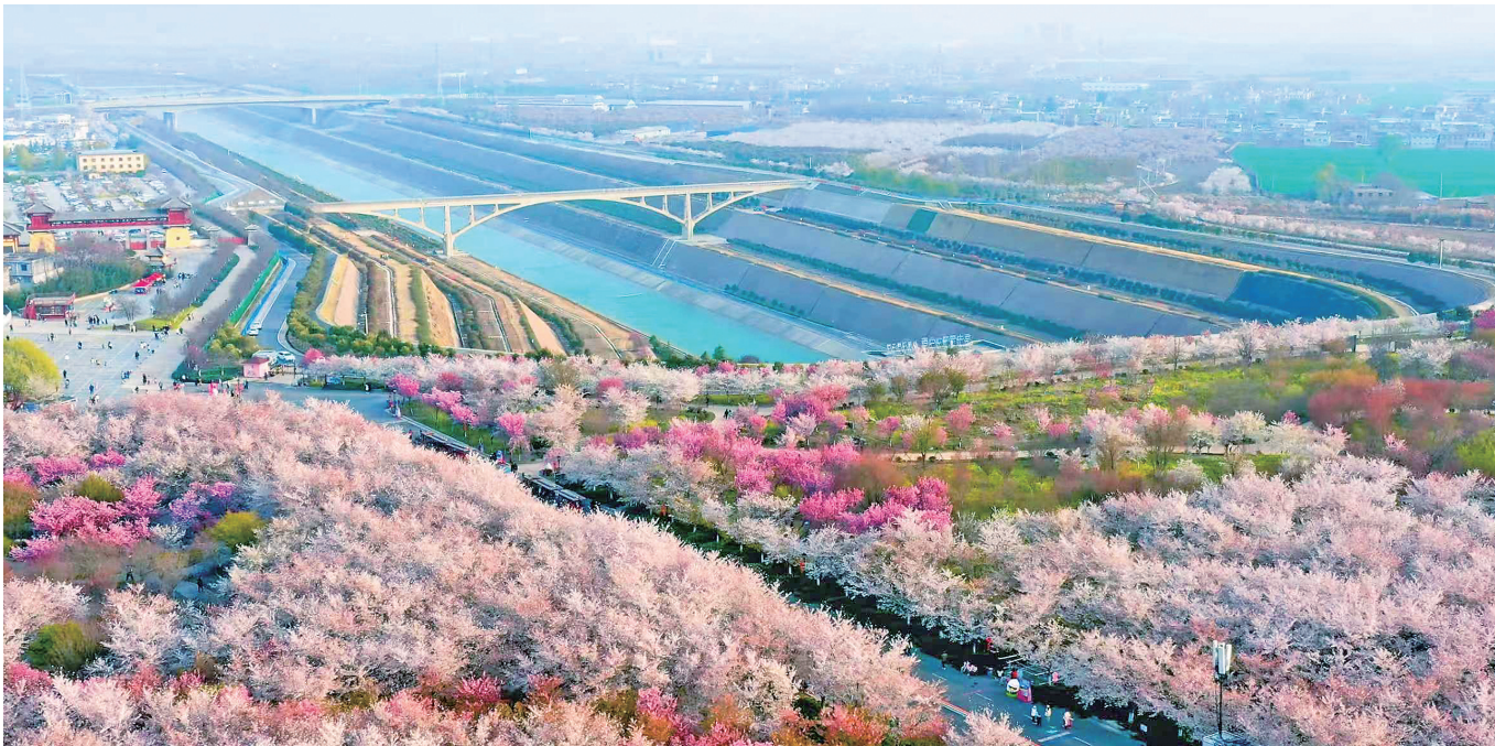
位于河南郑州荥阳的南水北调中线穿黄工程
