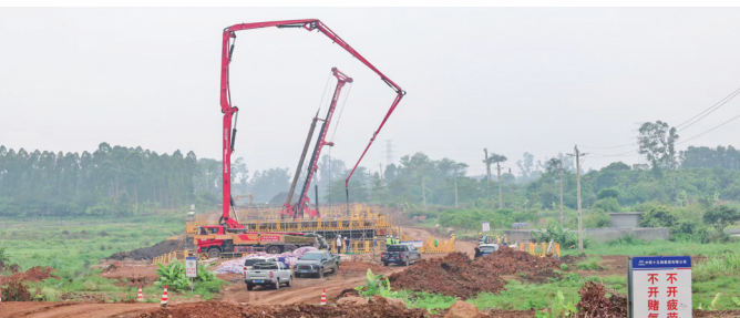
近日,由厦深铁路广东有限公司建设管理、中铁十五局承建的合湛铁路(广东段)站前2标首座框架桥顺利完工,这也是合湛铁路(广东段)全线首座主体完工的框架桥,标志着该项目建设取得阶段性进展。
