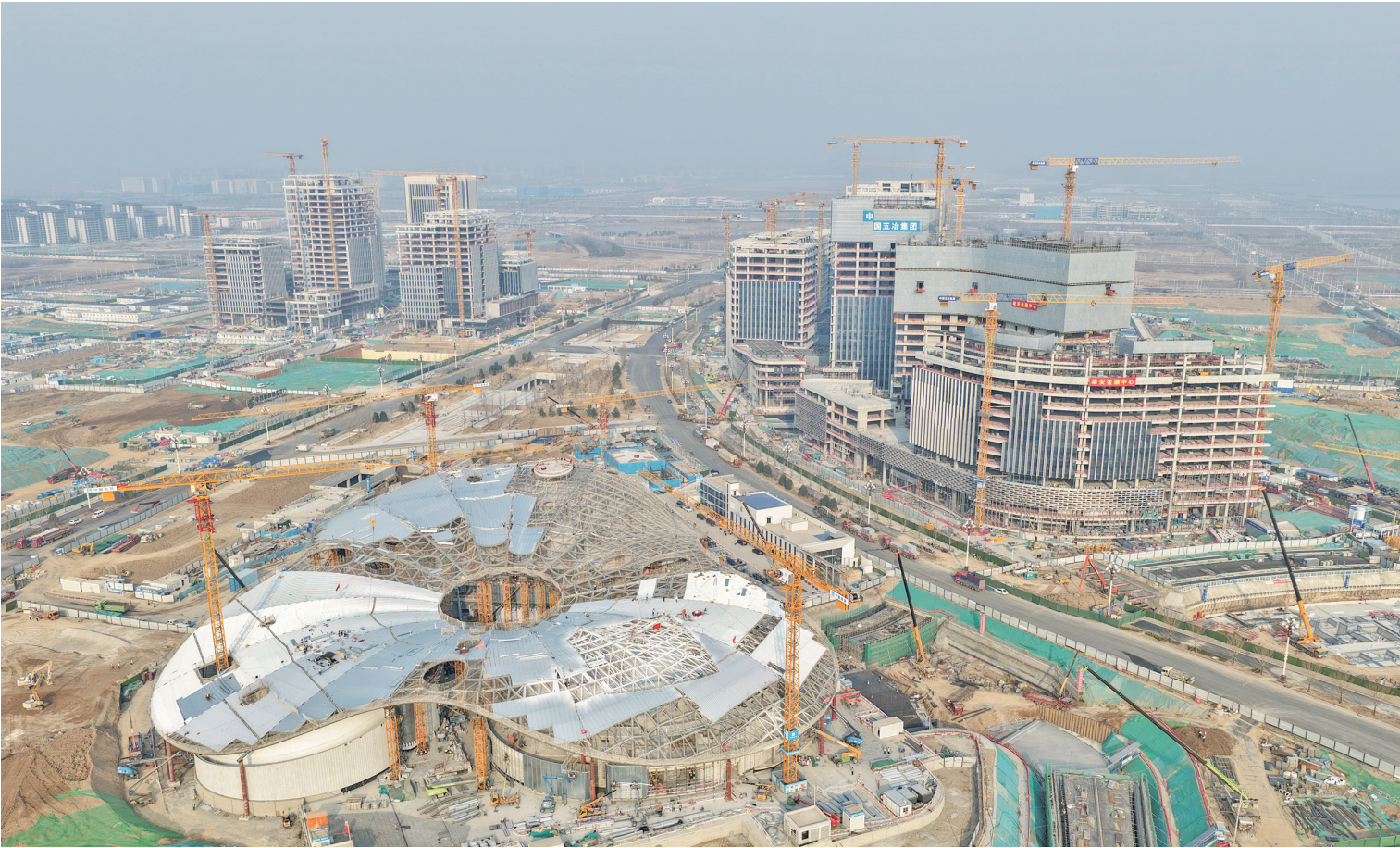
仲春时节，河北雄安新区各重点项目建设现场热热闹闹，建设者们坚守施工一线，保障工程建设持续推进。图为雄安新区城市文化广场(左)与雄安金融中心(右)建设现场。
