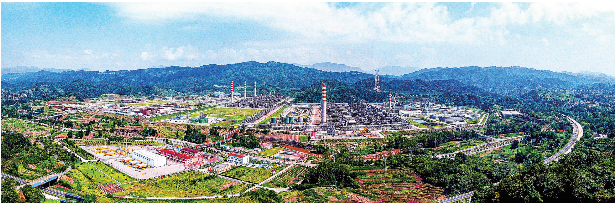
四川省达州市宣汉县天然气远景储量达1.5万亿立方米,拥有全国最大的海相整装气田——普光气田,是“川气东送”的气源地。图为中国石化普光天然气净化厂。
