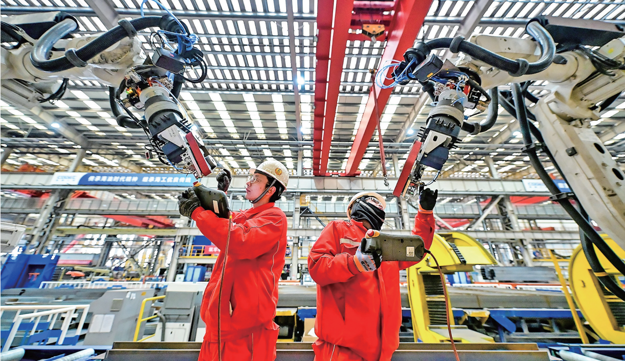
近日,在天津市滨海新区,海上油气平台建设工人操作打磨机器人。
