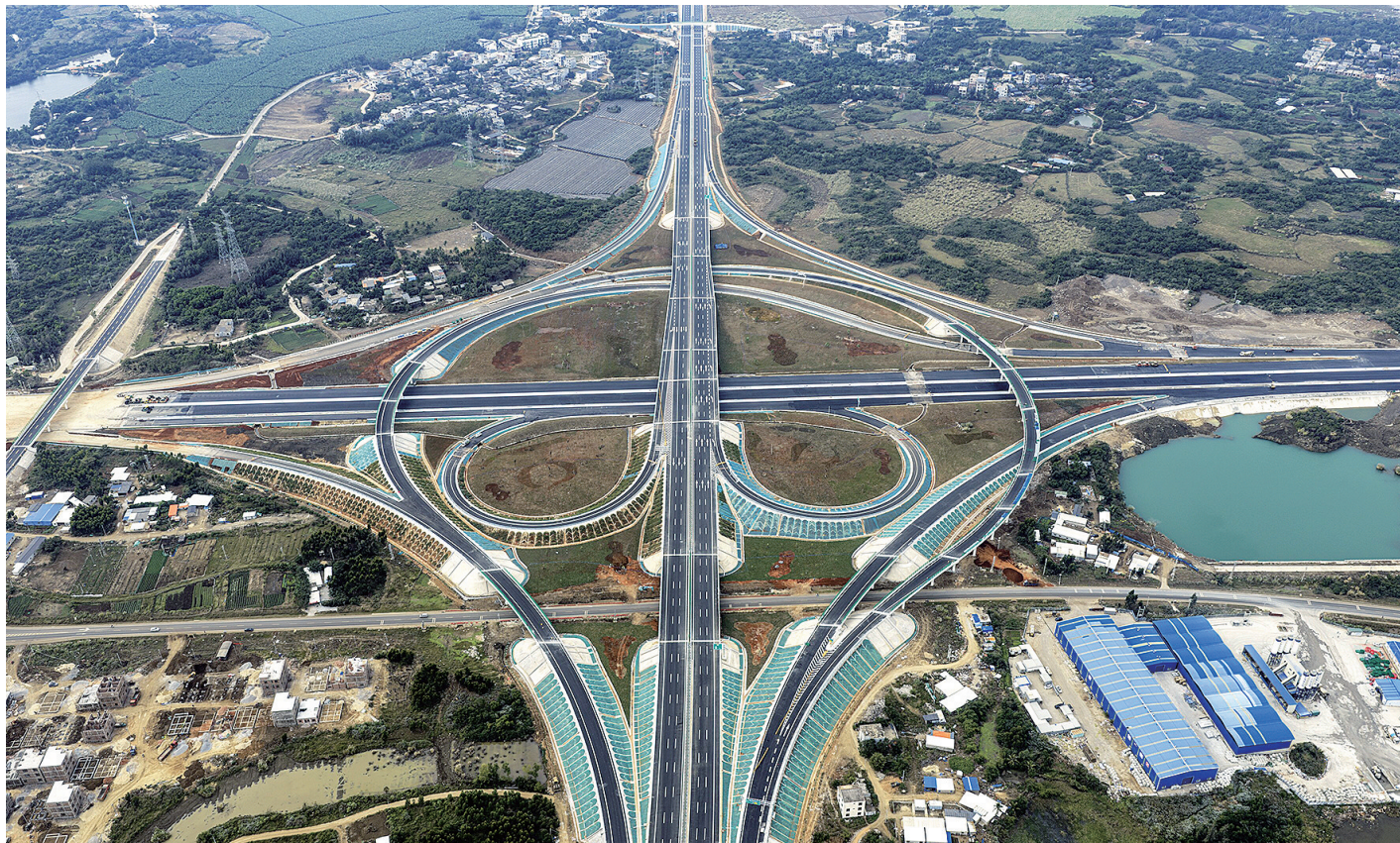
日前，海南省首条双向八车道高速公路——洋浦疏港高速公路正式建成通车。该项目全长35.338公里，北起儋州市东城镇，南接洋浦港，主线采用双向八车道高速公路标准，设计时速120公里。
