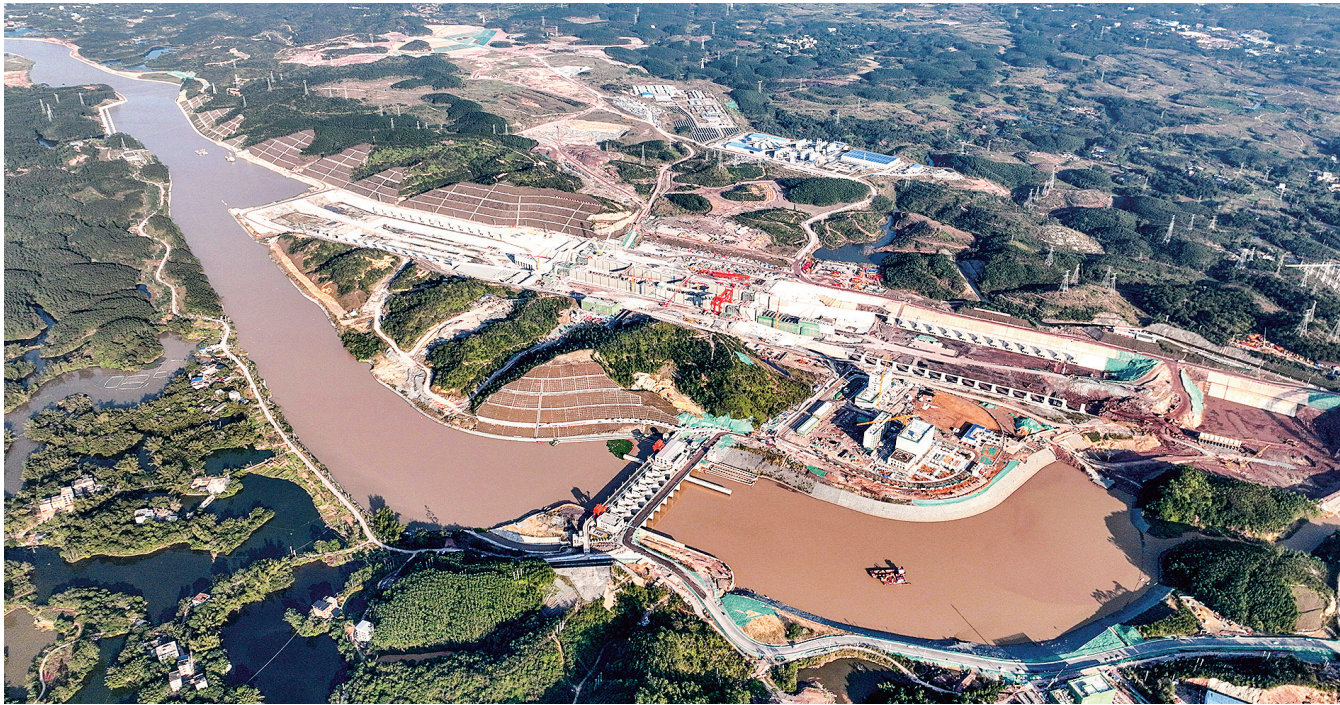
作为西部陆海新通道的骨干工程,平陆运河全长约134.2公里。工程建成后,将为我国西南地区开辟一条由西江干流南下入海的江海联运大通道。图为正在建设中的平陆运河青年枢纽。
