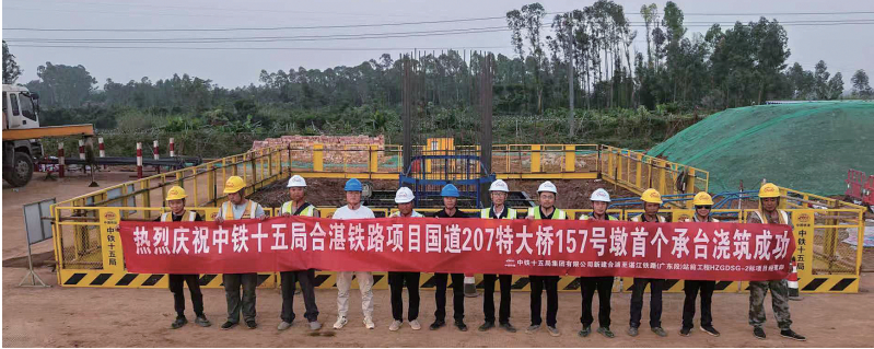
近日,随着罐车内最后一方混凝土的顺利浇筑,由厦深铁路广东有限公司建设管理、中铁十五局承建的合(浦)湛(江)铁路(广东段)项目首个桥梁承台浇筑完成,该项目建设迈入墩身施工新阶段,为后续桥梁施工奠定了坚实基础。 安艳军 摄
