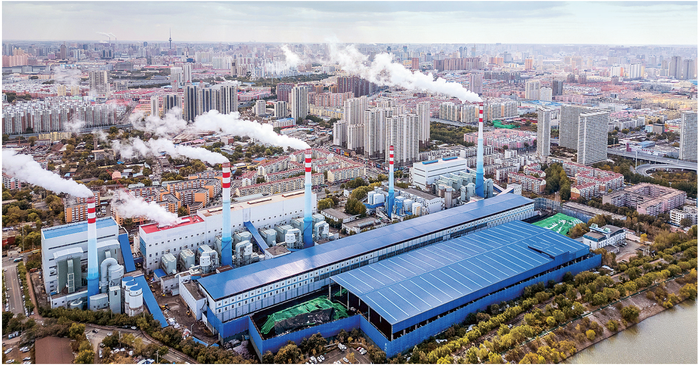
今冬供热以来,“冰城”哈尔滨主要供热企业充分利用智慧供热改造成果,提高供暖系统运行效率,实现精准供热、按需供热和平衡供热。图为哈尔滨市华能集中供热有限公司在进行供热作业。
