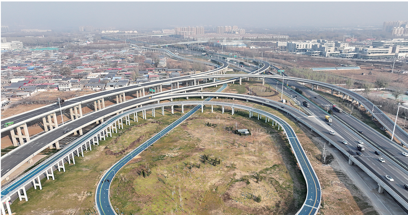
近日，河北省石家庄市环城绿道跨石太铁路转体桥工程完工，标志着全长101公里的环城绿道全线贯通，市民可实现环城无障碍骑行、慢跑和休闲健身。
