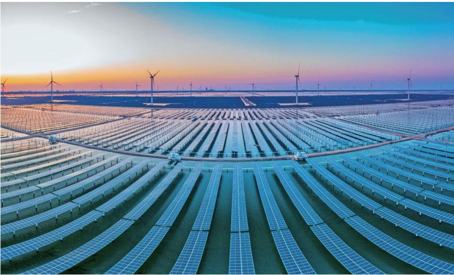
山东滨海能源有限公司(隶属海化集团)海化滨能光伏一期300MW光伏发电项目
