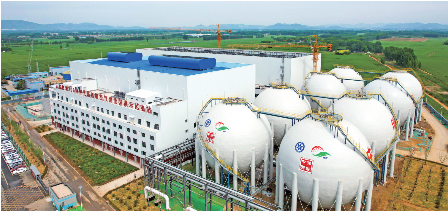
国内首台套10兆瓦盐穴储能项目、全球最大规模300兆瓦项目已投产。(泰安市委宣传部供图)
