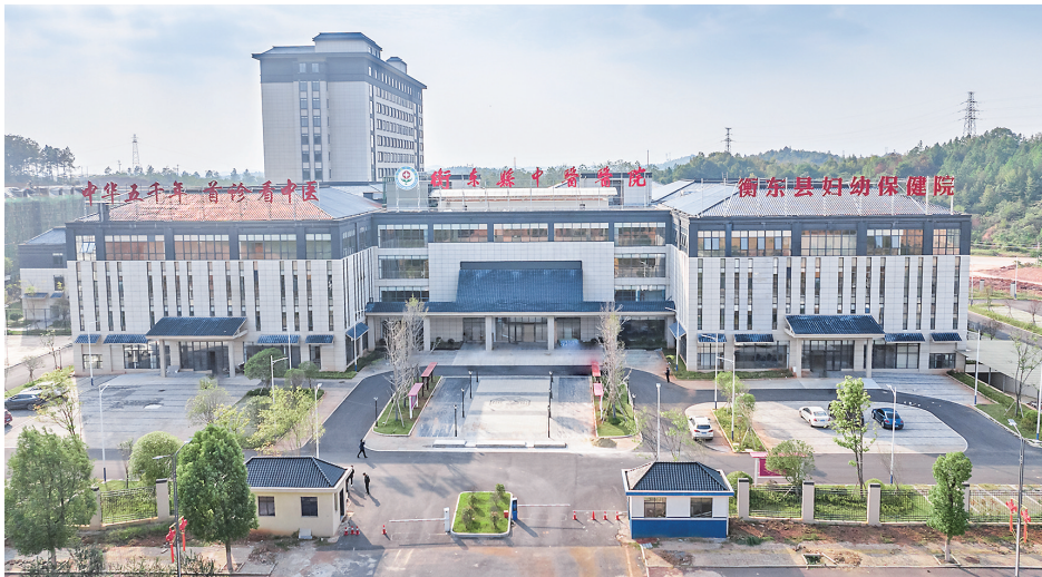
衡东县中医医院、妇幼保健院河西新院航拍图。
