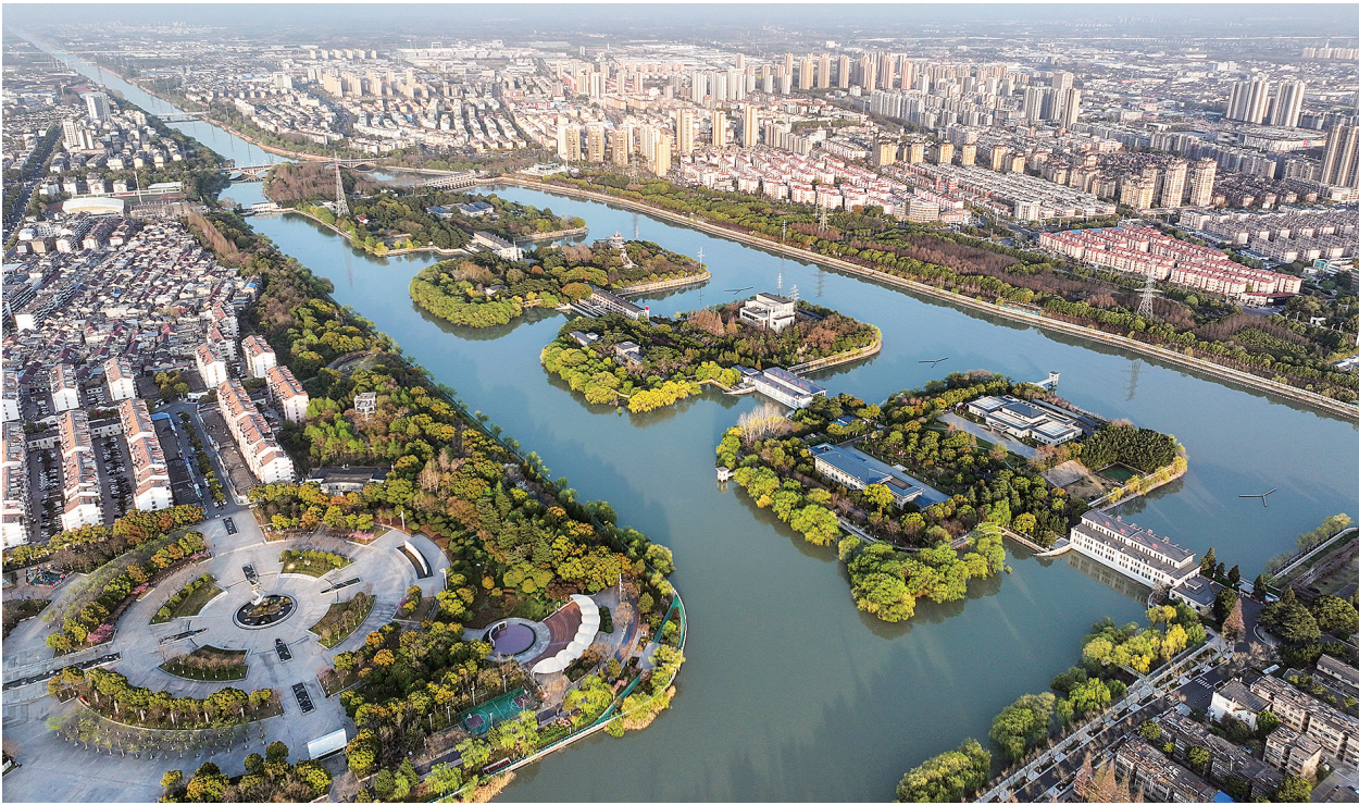
一江两岸展“绿卷”,生态图景绘丹青。在这江河湖海的交汇处,江苏以水为笔,绘就大江大河新画卷。图为南水北调东线源头工程江都水利枢纽。
