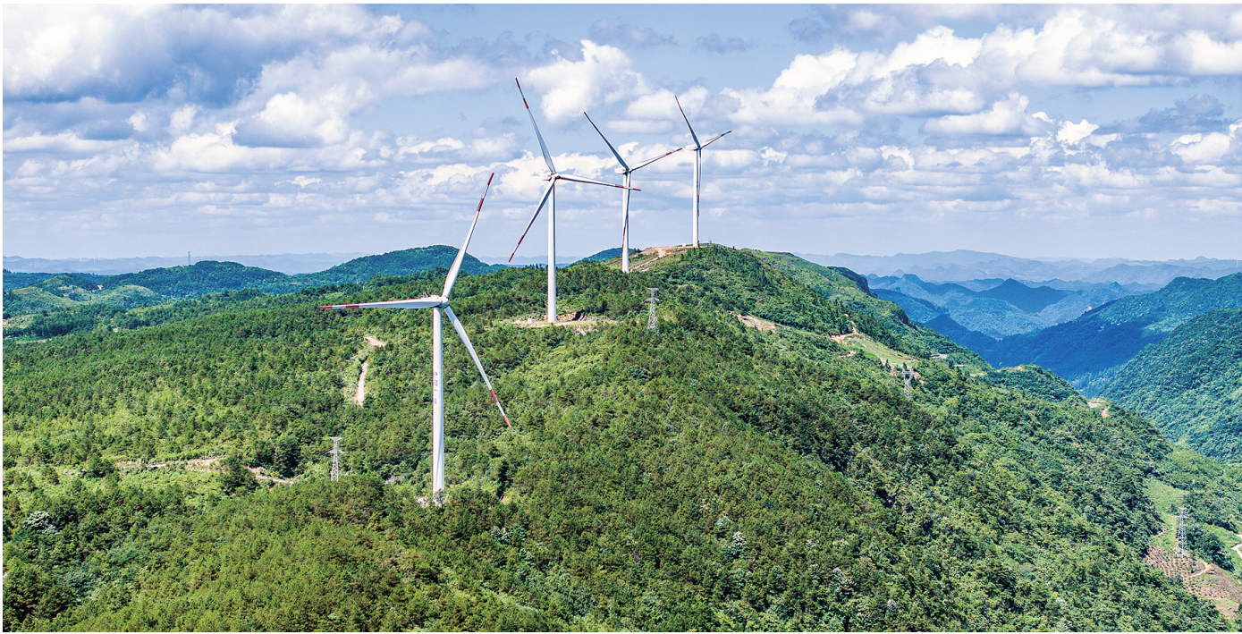
近年来，贵州加快构建新型综合能源基地，建设先进煤电机组，有序发展风电、光伏等新能源产业，推动建设西南区域电力枢纽，努力构建清洁低碳、安全高效的现代化能源体系。图为位于龙里县的风力发电设施。
