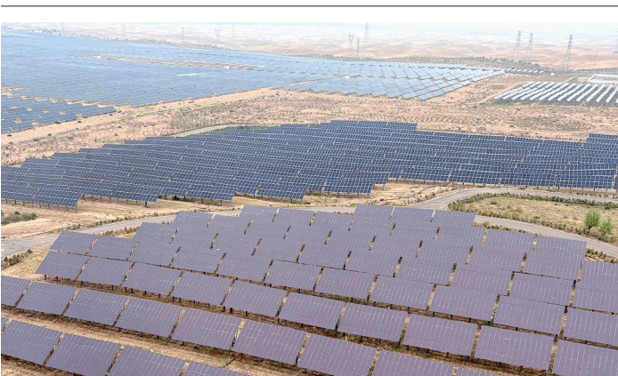
达拉特旗光伏发电应用领跑基地
