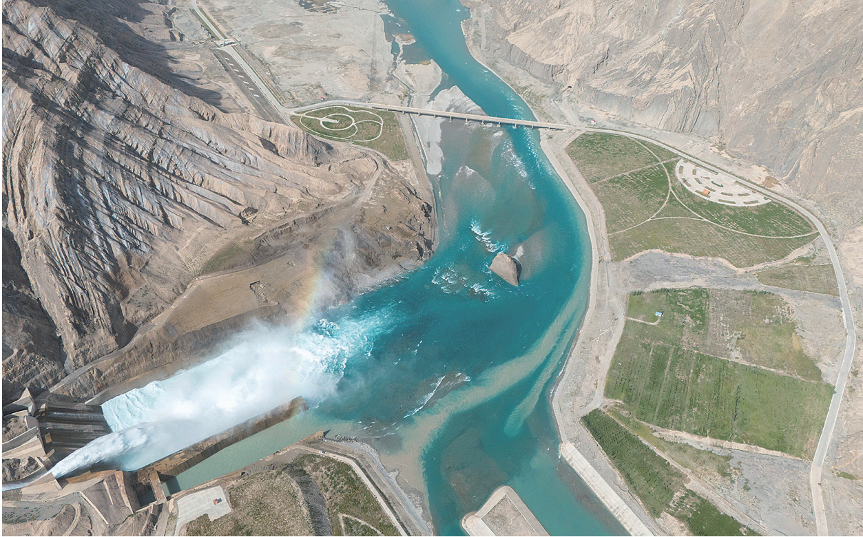
阿尔塔什水利枢纽工程是新疆目前规模最大的水利枢纽工程,兼顾生态、防洪、灌溉、发电等功能,2021年8月建成投产以来,平均每年向塔里木河干流生态补水约3.3亿立方米。
