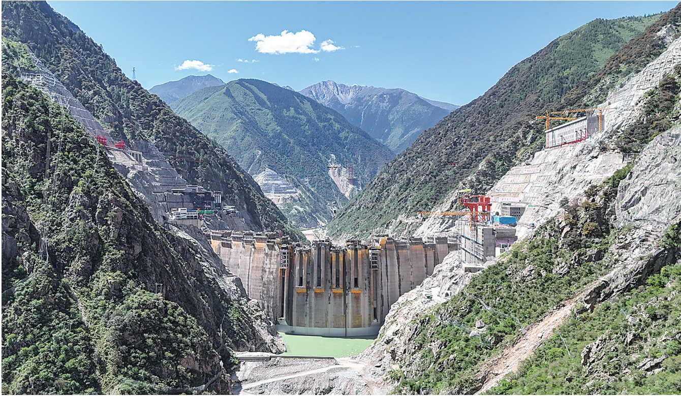
图为建设中的叶巴滩水电站。该水电站地处四川甘孜州白玉县与西藏昌都市贡觉县交界处的金沙江上游。
