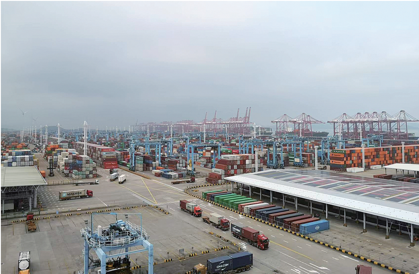
位于宁波舟山港梅山港区的梅东集装箱码头，年集装箱吞吐量已经超过1100万标准箱，码头坚持智慧化、绿色化双轮驱动，成功走出了一条绿色低碳智能化发展的道路。
