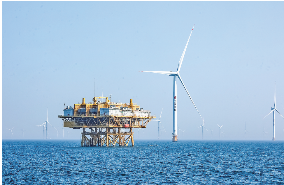
国家电投山东公司建成的山东首个百万千瓦级海上风电基地
