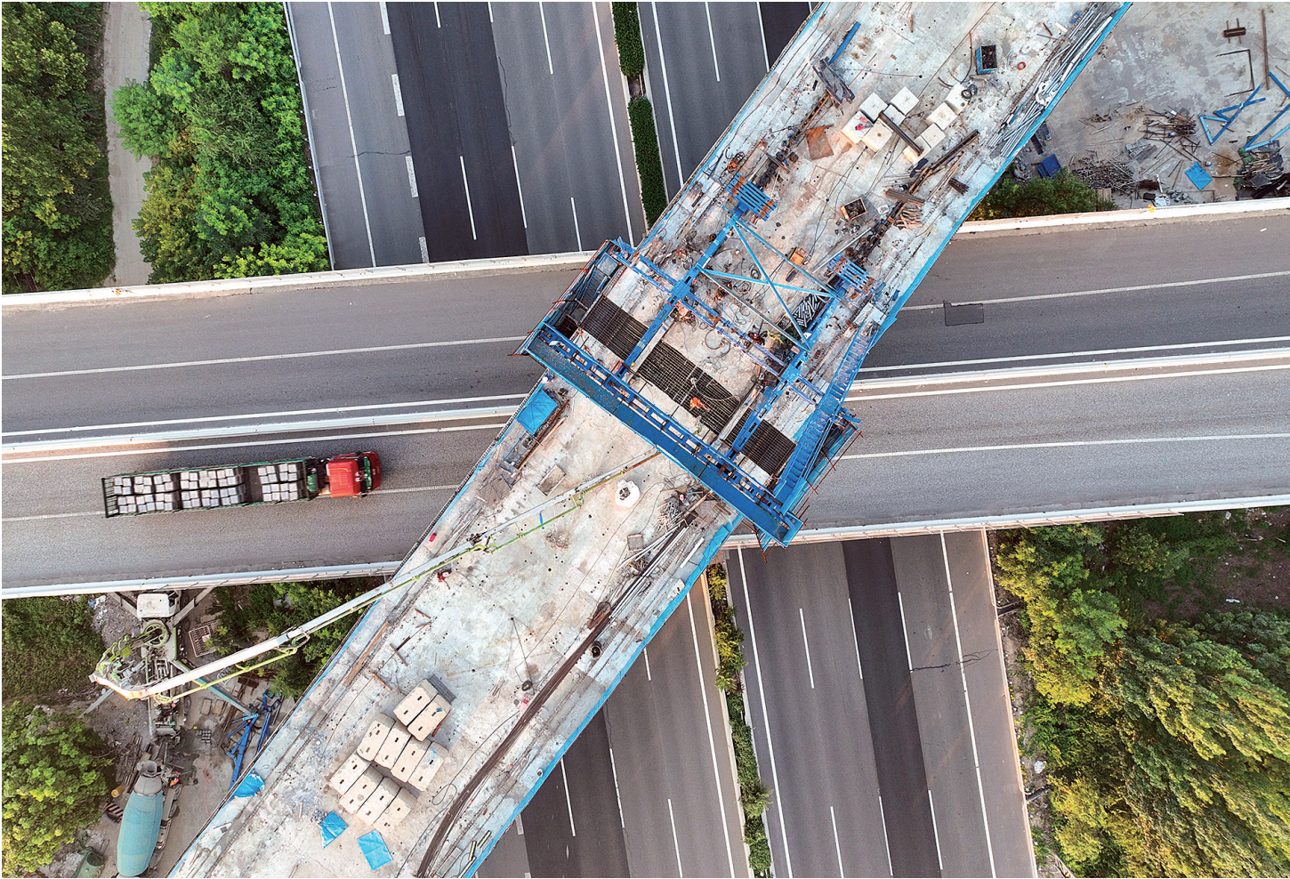
雄忻高铁起自雄安站,终到忻州西站,正线全长342公里,是我国“八纵八横”高速铁路网京昆通道的重要组成部分。图为雄忻高铁保定东特大桥跨京港澳高速连续梁中跨施工现场。
