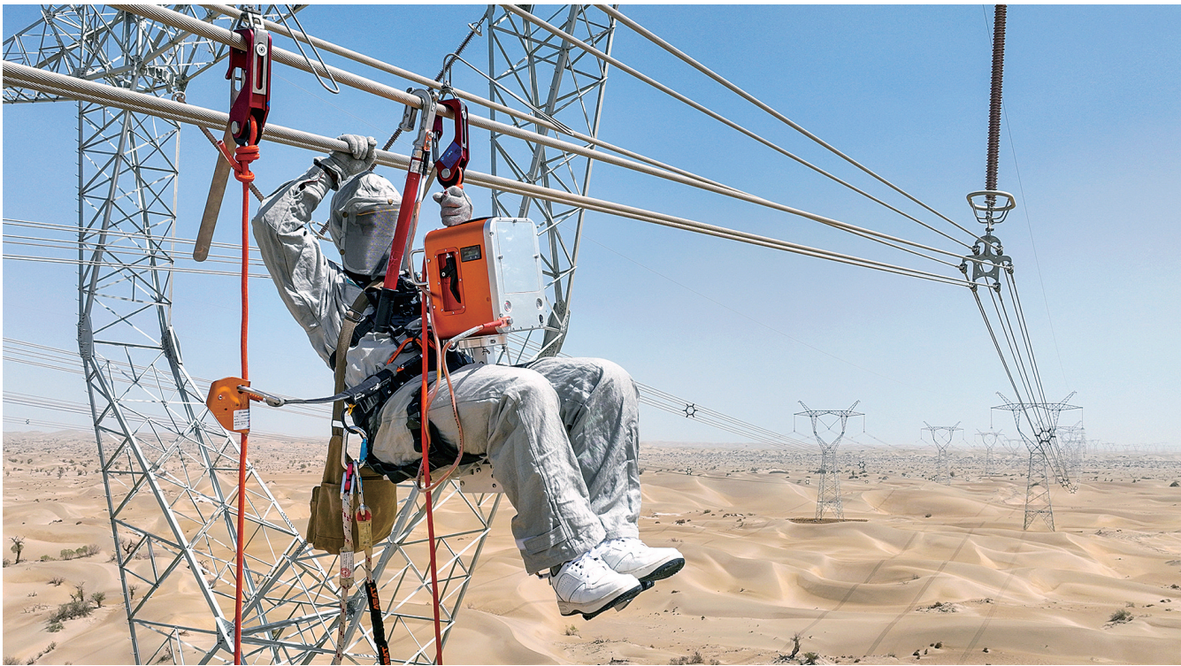
7月13日,历时15年建设的环塔里木盆地750千伏输变电工程全线贯通,形成了一条围绕塔里木盆地的750千伏超高压输电环网。图为电力员工开展带电消缺作业。
