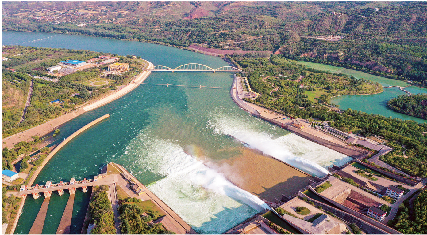
日前,水利部黄河水利委员会通过联合调度万家寨、三门峡、小浪底等水库,启动实施2025年黄河调水调沙,本次调水调沙将历时17天左右。图为在河南济源拍摄的小浪底水利枢纽工程调水调沙现场。
