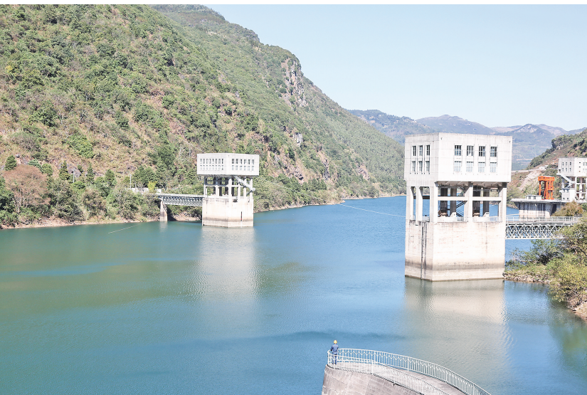
鲁布革水电站坐落于云南与贵州之交的黄泥河上,在这里建成了新中国第一座风化石料心墙堆石坝。
