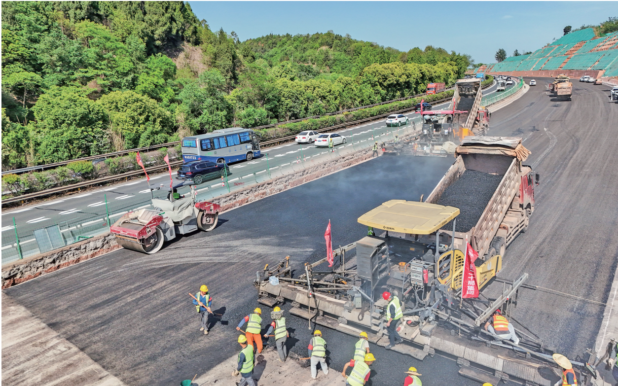
“五一”假日期间,四川各地重点建设项目承建方抢抓工期与节点,一线建设者坚守岗位,确保重点项目建设如期稳步推进。图为四川省成都市金堂县的成南高速扩容工程现场,中铁二十局的工人正在进行路面摊铺施工。
