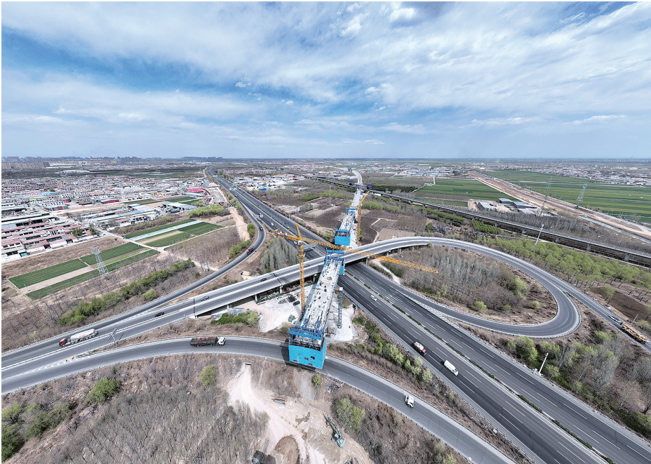
目前,雄忻高铁雄安—保定段连续梁施工正在加速推进。雄忻高铁起自河北雄安新区,终到山西忻州西站,正线全长342公里,是我国“八纵八横”高速铁路网中京昆通道的重要组成部分。项目建成后,将显著提升保定的交通枢纽地位,为京津冀协同发展提供更加便利的交通保障。
