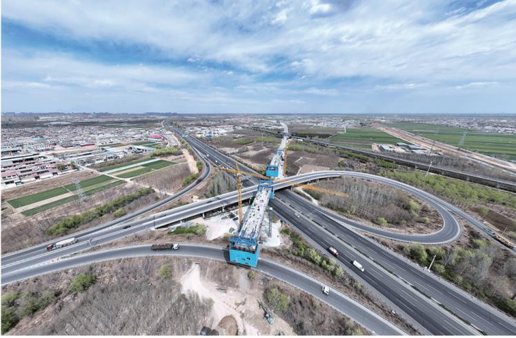
目前，雄忻高铁雄安—保定段连续梁施工正在加速推进。雄忻高铁起自河北雄安新区，终到山西忻州西站，正线全长342公里，是我国“八纵八横”高速铁路网中京昆通道的重要组成部分。项目建成后，将显著提升保定的交通枢纽地位，为京津冀协同发展提供更加便利的交通保障。
