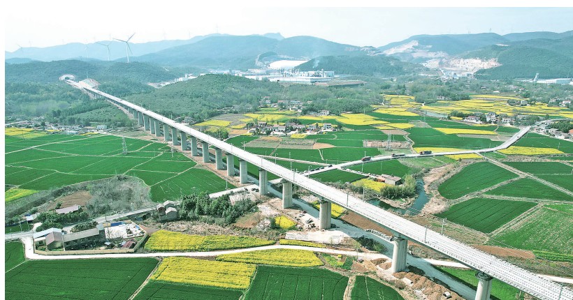
近日,由中铁十五局参建的襄荆铁路项目全线无砟轨道顺利完工,项目取得重大进展。
