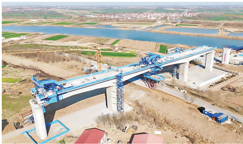
近日,由中铁十五局承建的津潍高铁海兴特大桥跨漳卫新河北河堤连续梁合龙。
