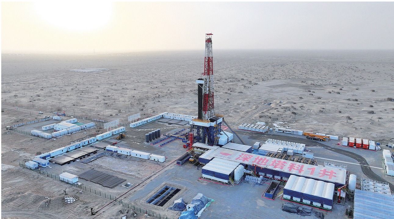
万米深井的成功钻探,标志着我国特深井关键核心装备和技术,通过了万米极端恶劣工况环境的检验,不仅丰富了我们钻井工程领域的工程技术系列,更为挑战深地极限、开发超深层油气资源提供了坚实的装备保障。
