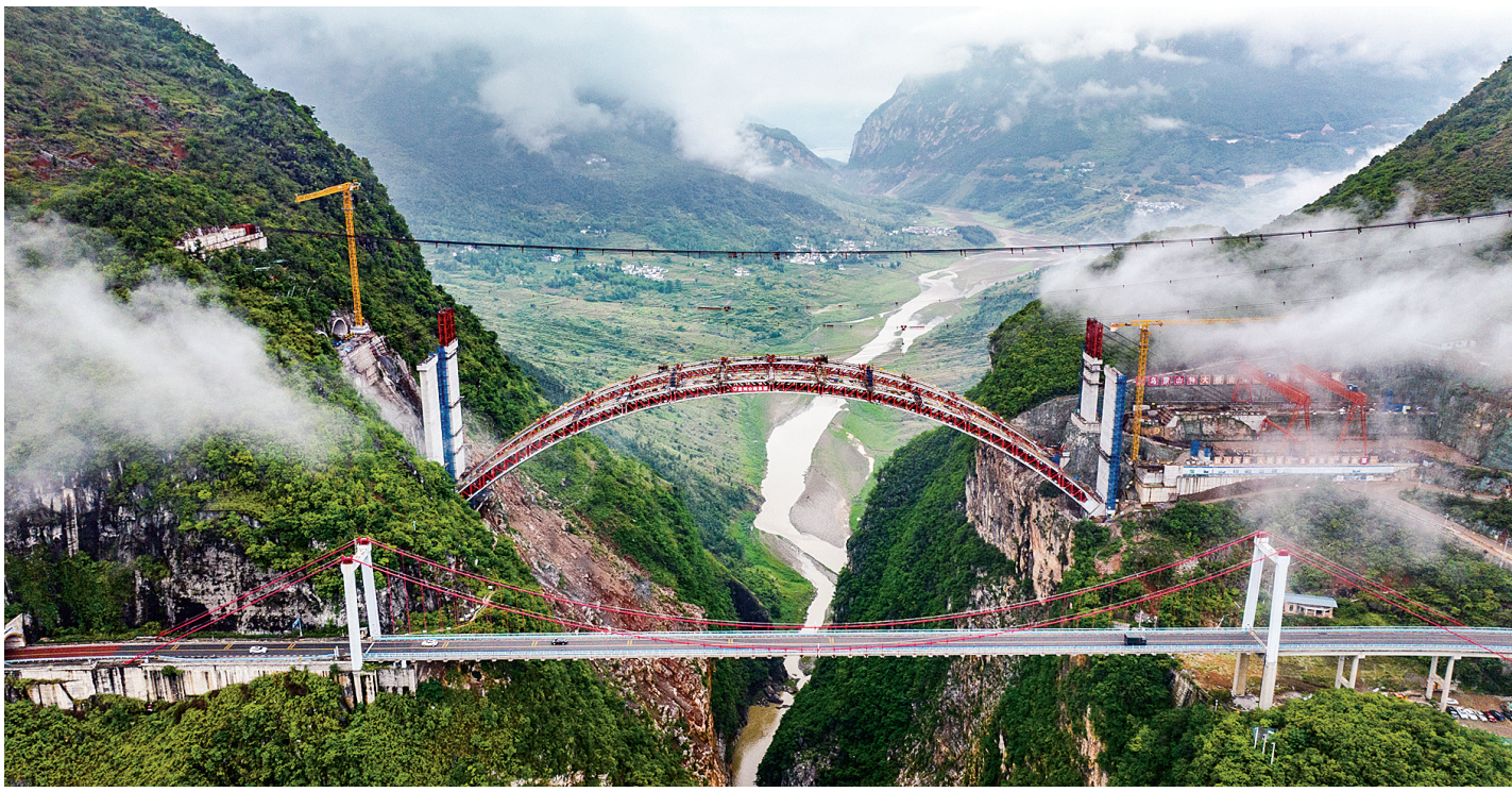
按照规划，贵州省大力推进交通建设，目前已建成公路20余万公里，已建和在建桥梁近3万座，囊括几乎所有桥型，成为名副其实的“桥梁博物馆”。预计“十四五”末，贵州高速公路里程将达9500公里，高速公路出省通道将达29个。一座座架设在高山峡谷间的大桥，让“地无三里平”的贵州实现了从“千沟万壑”到“高速平原”的巨变。图为建设中的纳晴高速乌蒙山大桥。
